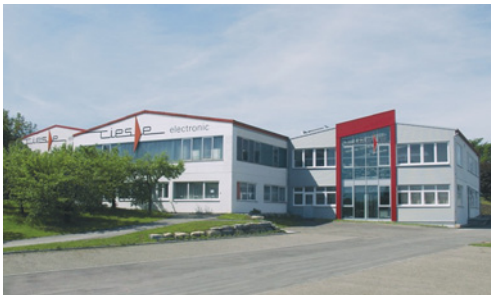
Das Firmengebäude der Riese-electronic GmbH in Horb – heute
